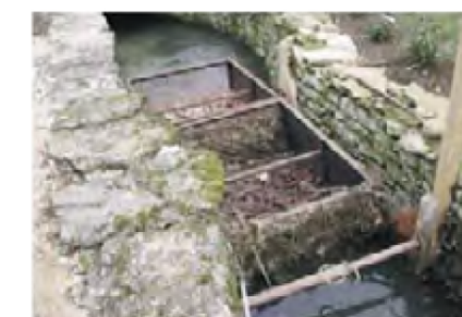
Filtre mobile installé sur un cours d'eau
